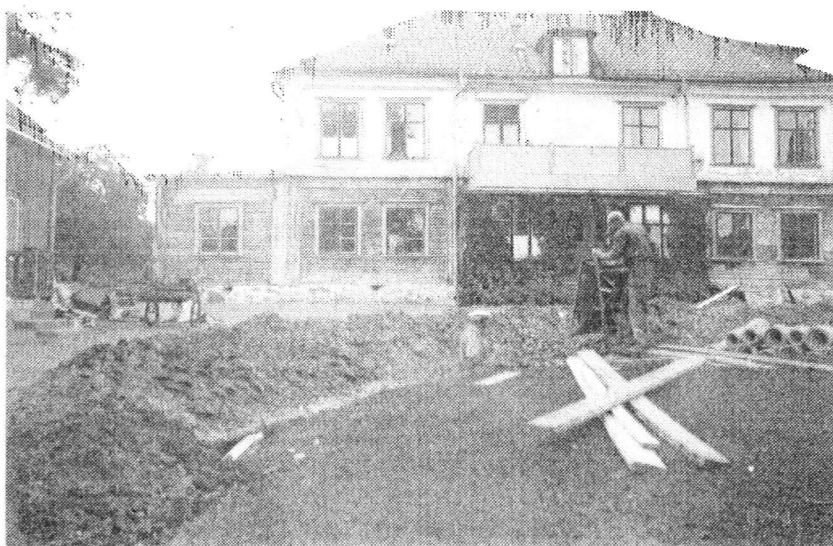
Reveteringen knackas ned och timmerstommen blottläggs. Foto Birgit Kölzow.
