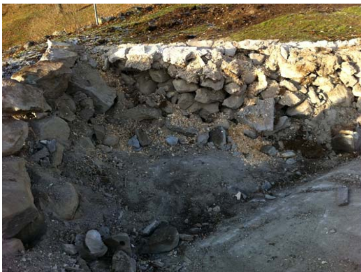
Den ursprungliga grunden var av natursten som putsades och vitalkades på utsidan.
