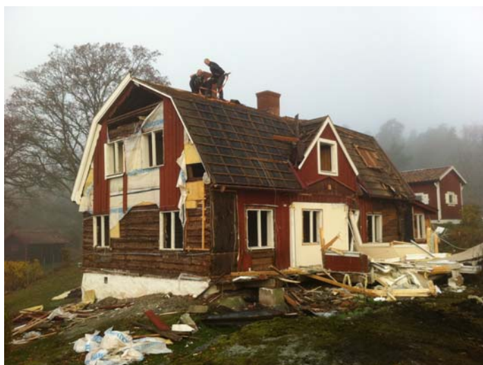
Östra och södra fasaden.
