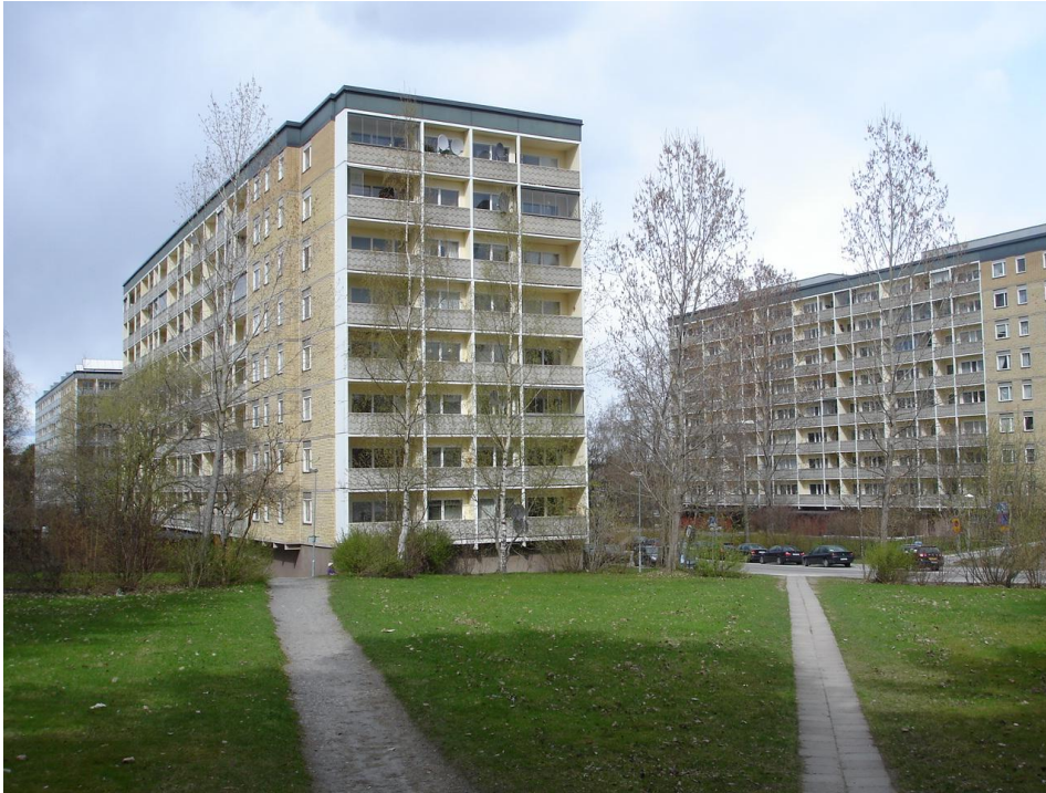
Parkmarken med gångvägar och skivhusens sydfasader
