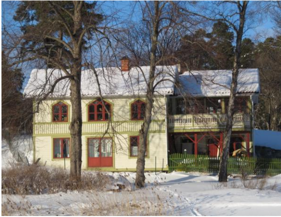
Björkuddsvägen 12, fasad mot Maren. Foto 2010
