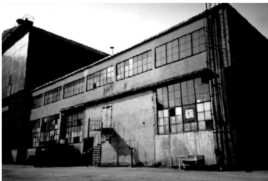
Svetsverk- städerna år 1998 innan rivningarna påbörjades. Foto Nyréns Arkitektkontor
