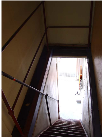
Bilder från för- rådsbyggnaden i tegel. Ståltrappan är ursprunglig. Relax- avdelningen är från 1990-talet.
