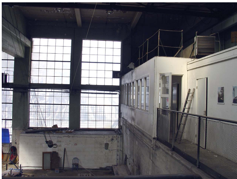
Rörverkstaden är en dubbelhall med kraftiga pelare och blakar i mitten. Entresolen är ursprunglig med har sentida påbyggnader.
