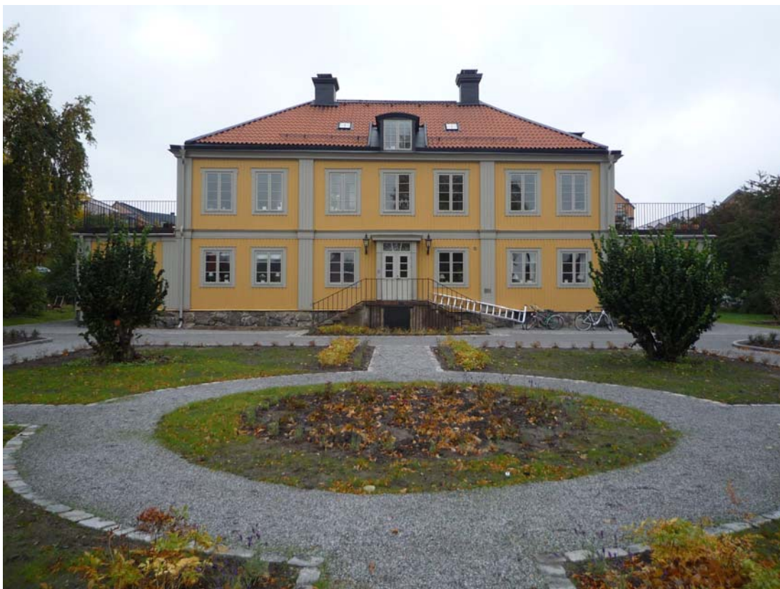
Herrgården 2010. Vid denna renovering har fasaden målats, skorstensskydd och takfönster tillkommit.
