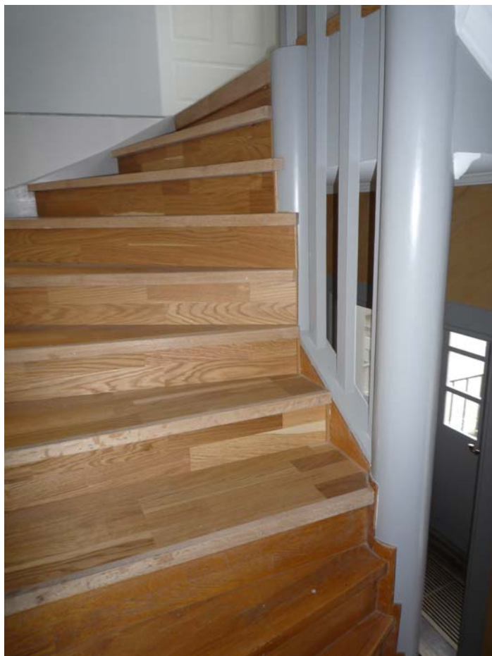
Herrgården, trapphuset år 2001 och 2010. Trappans övre trapplopp har vridits 90 grader.
