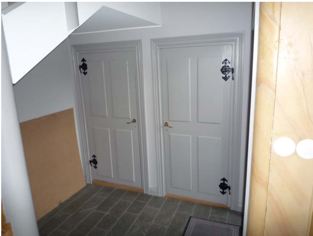
Dörrarna har flyttats till huvudbyggnadens entréhall. Gångjärnen bör historiskt sett vara målade i dörrfärgen.
