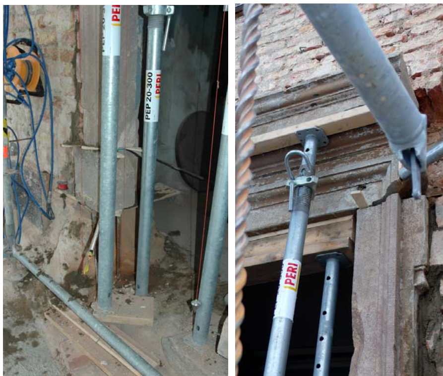
Norra portalen under restaurering. Under arbetet fixerades portalens delar i sina rätta lägen varefter den murades samman. 2008-12-16 och 2008-10-27 Nedan deltalj av östra portalen med nyhugget karmparti mitt i bild. 2009-02-25 Den nyhuggna delens ytbearbetning kallas lågerhuggning.
