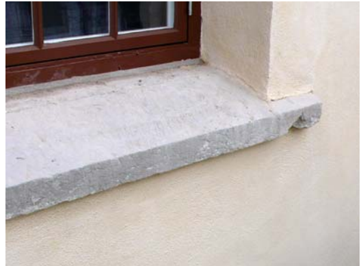
Ovan fönsterbänk efter konservering och återmontering. 2009-02-25 Nedan portal åt väster efter bemålning. Lägg även märke till den nytillverkade porten. 2009-10-12
