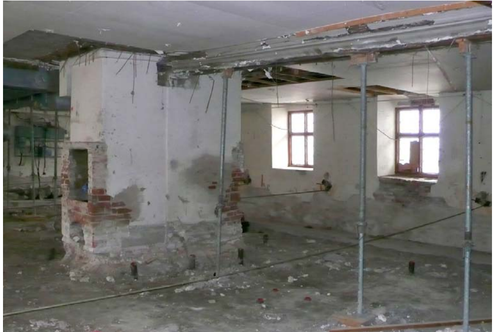
Ovan interiör av röda salen före restaurering. Lägga märke till stämp och dragband av stål. 2008-10-02 Nedan detalj av den mycket kraftiga ursprungliga taklist som omramade var och en av salarna. 2008-12-16
