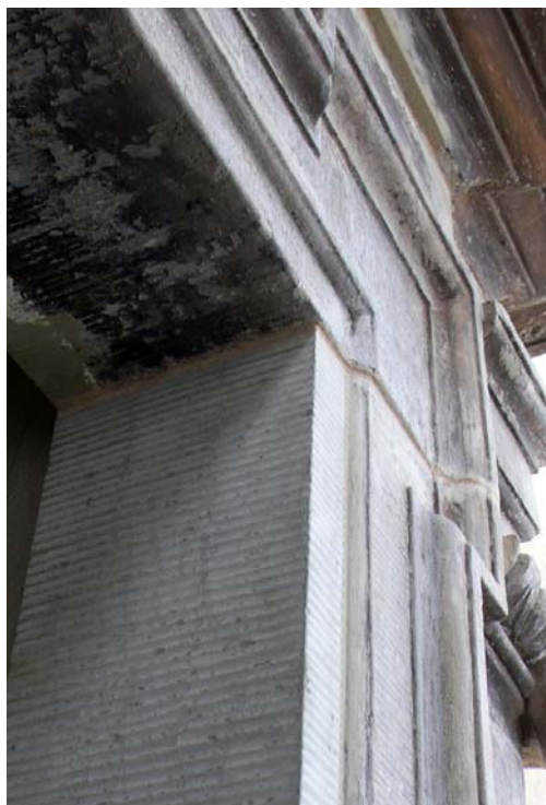
Norra portalen under restaurering. Under arbetet fixerades portalens delar i sina rätta lägen varefter den murades samman. 2008-12-16 och 2008-10-27 Nedan deltalj av östra portalen med nyhugget karmparti mitt i bild. 2009-02-25 Den nyhuggna delens ytbearbetning kallas lågerhuggning.
