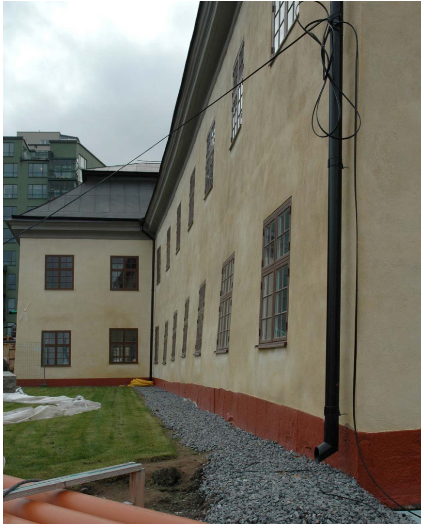
Sockel efter restaurering och bemålning. 2009-10-12
