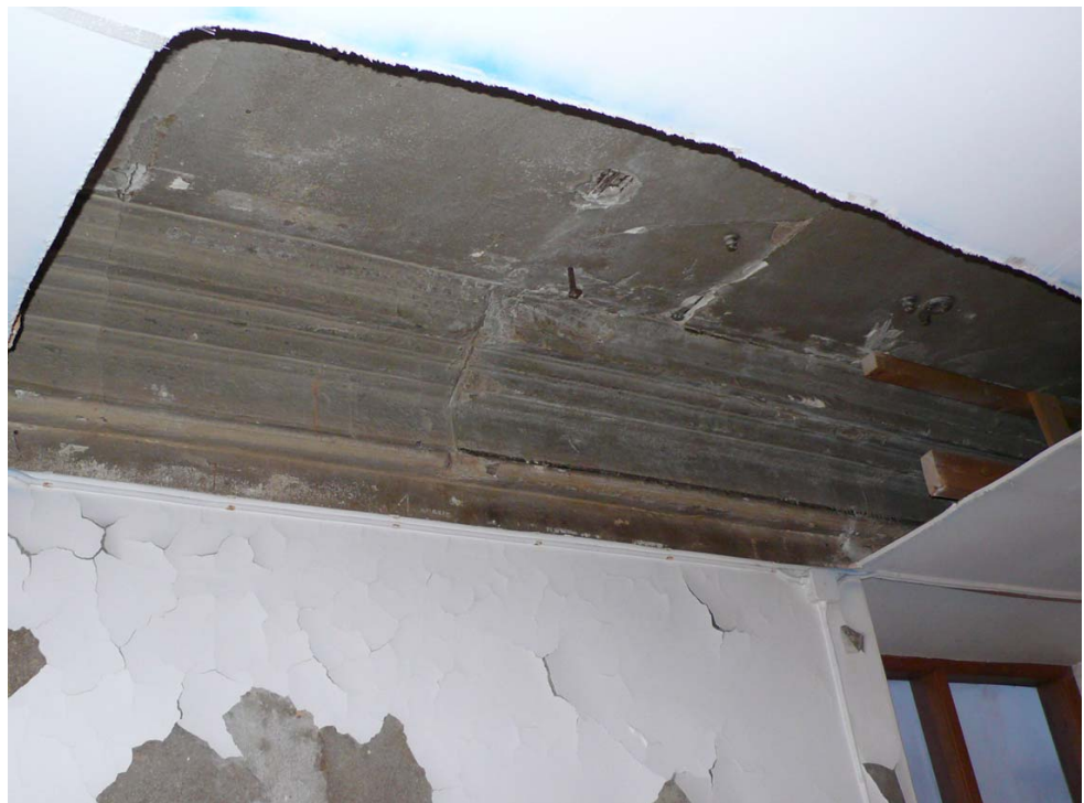
Ovan interiör av röda salen före restaurering. Lägga märke till stämp och dragband av stål. 2008-10-02 Nedan detalj av den mycket kraftiga ursprungliga taklist som omramade var och en av salarna. 2008-12-16
