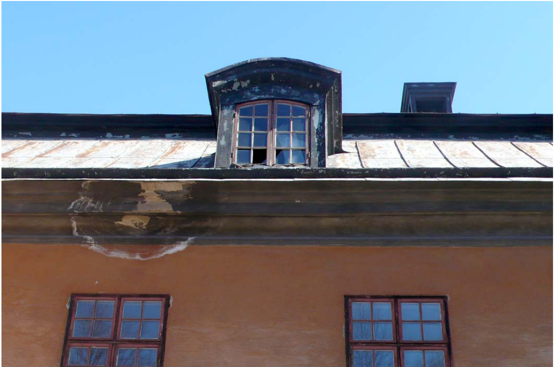
Tak och takkupa med stånfalsat plåt i skivtäckning. 2008-04-21
