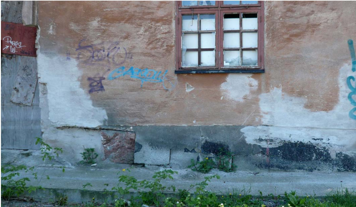
Ovan sockel i gavelfasad åt norr. Asfaltsbestruken sockel där delar av roslagssandstenen är exponerad. 2008-05-23
