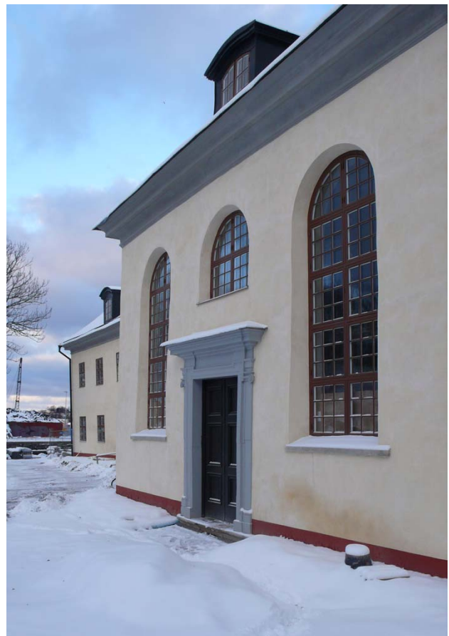
Kyrkfönstren åt väster efter restaurering. 2009-12-16
