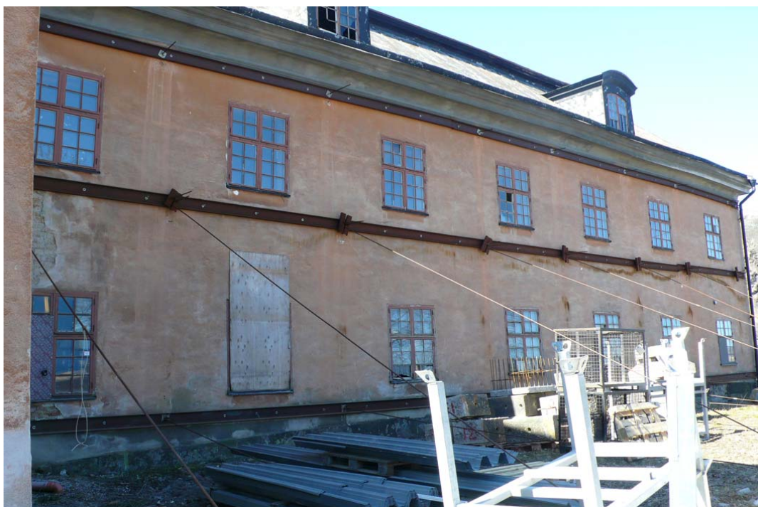
Västfasaden ovan och norra flygelns östfasad nedan. Lägga märke till de konstruktiva förstärkningarna med balkar och dragband av stål. 2008-05-05
