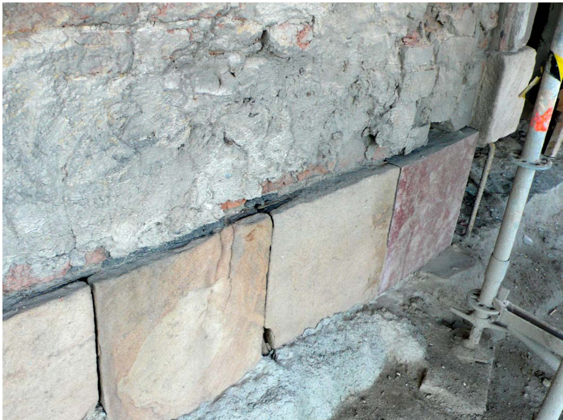
Sockel åt norr med rengjorda befintliga stenskvivor och nyhuggna, kompletterande delar. 2008-11-13
