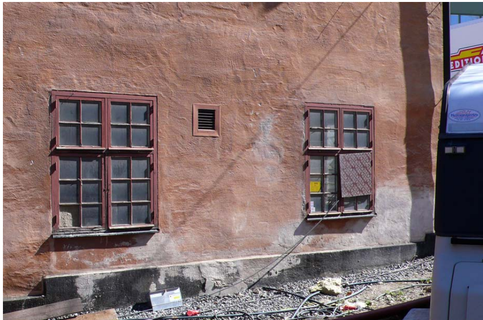
Parti av södra flygelns västra fasad. 2008-04-21
