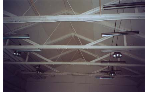
Öppna takstolar av järn i flyglarna mot vattnet, samt av trä med järnstag i provrummet. Lägg märke att lanterninen är igensatt. Foto 2000
