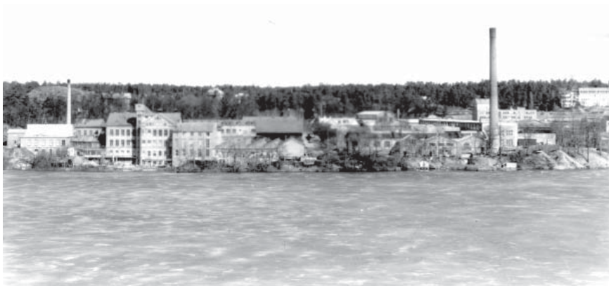
Ovan: Järla industriområde från vattnet 1950, se ångpannerummet strax innan påbyggnaden.
