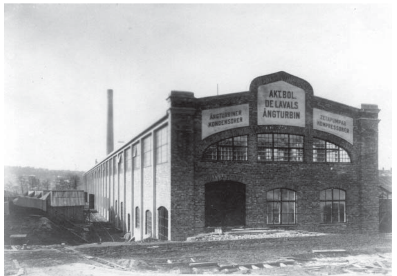
Turbinhallen under uppförande 1911, ur Nacka lokalhistoriska arkiv.
