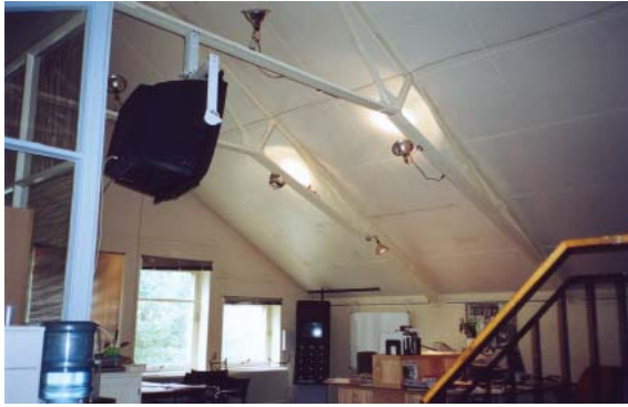
Öppna takstolar av järn i flyglarna mot vattnet, samt av trä med järnstag i provrummet. Lägg märke att lanterninen är igensatt. Foto 2000
