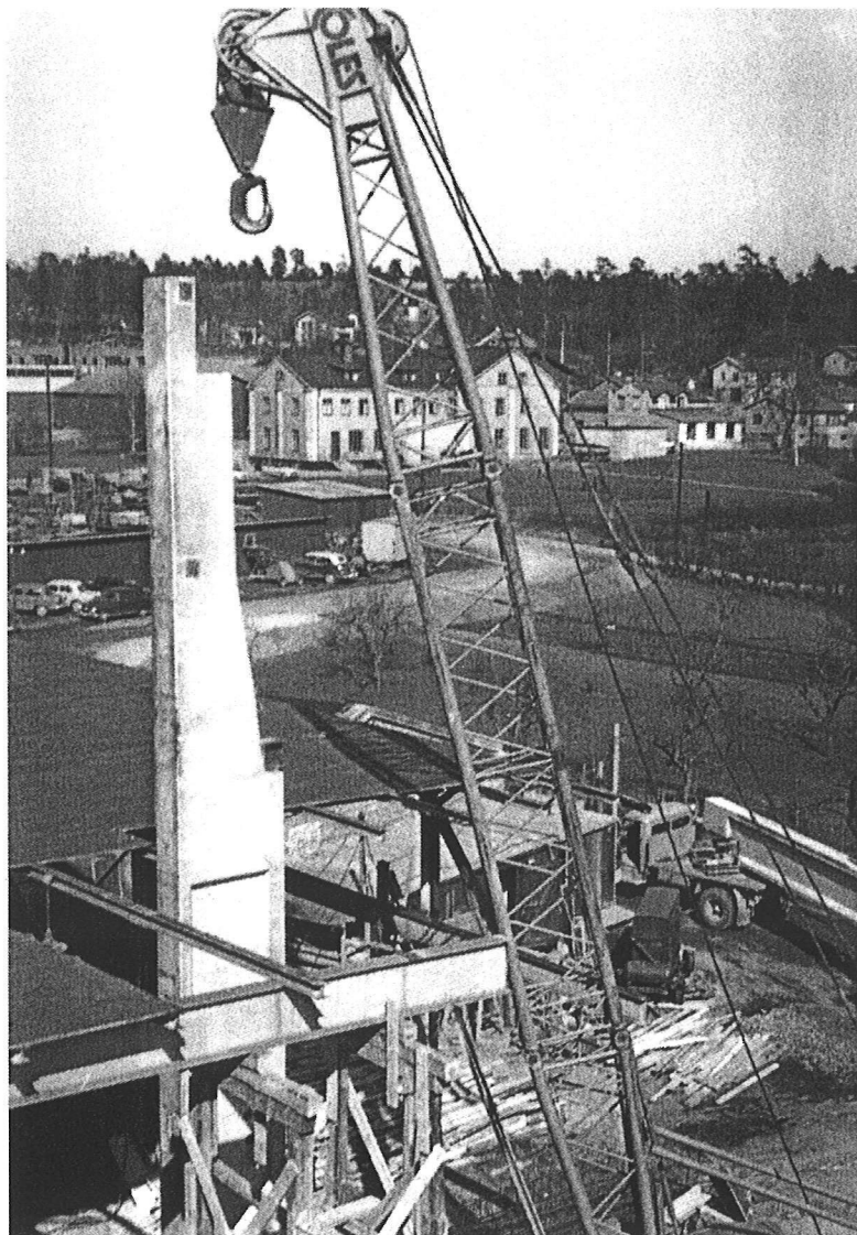
Fotografi från byggandet av nya monteringshallen 1958. Ur Nacka lokalhistoriska arkiv.
